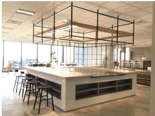
コの字型カウンター／天吊棚の柱先端にLEDダウンライトを取り付け
