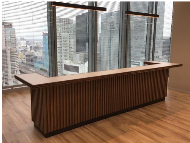
カウンター W4070*D900*H1020 腰部はウォールナット突板で特注リブ材を貼っている
